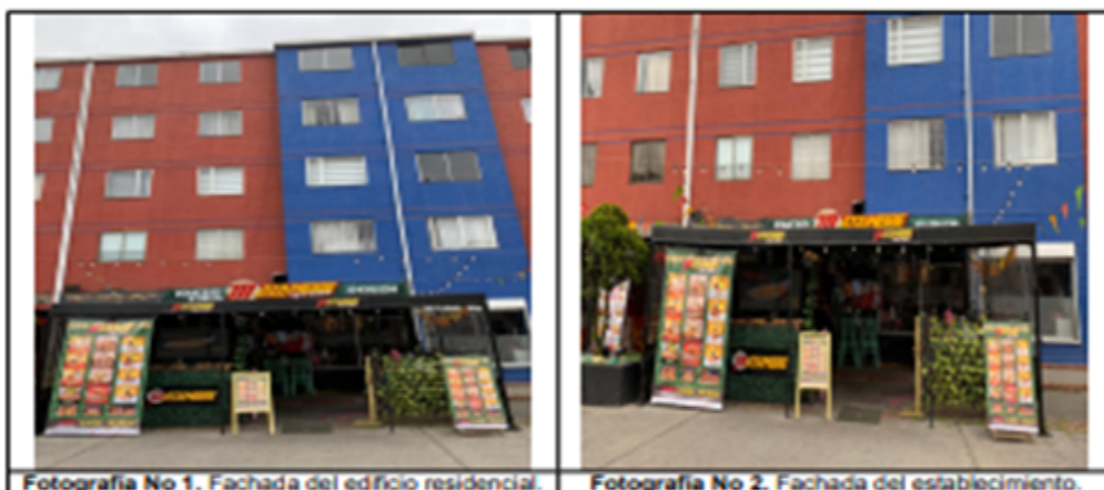
Fotografía No 1. Fachada del edificio residencial.
